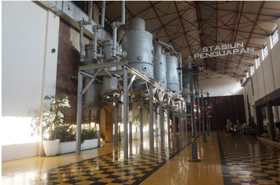
Gambar 2. Bekas ketel pada interior De Tjolomadoe sumber: A.A S. Fajarwati, 2019
