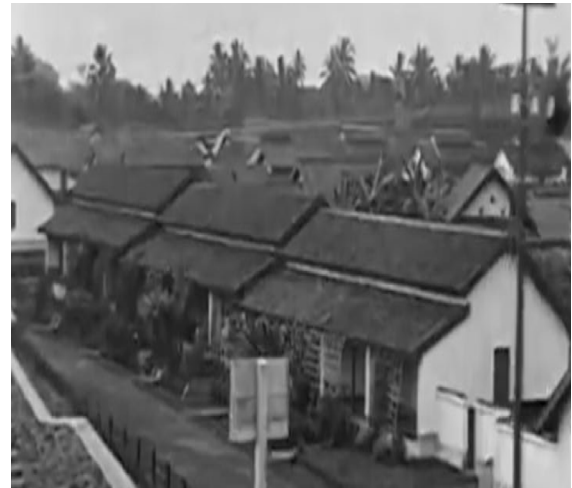
Gambar 4. Rumah Tipe Kelas 2 Perumahan SS di Manggarai (Sumber: Dok. Eyefilm)
