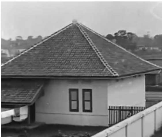
Gambar 3. Rumah Tipe Kelas 2 Perumahan SS di Manggarai (Sumber: Dok. Eyefilm)
