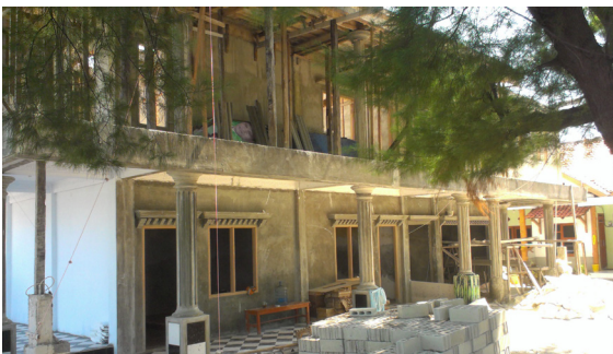
Gambar 11. Pembangunan homestay yang makin marak di Kep. Seribu
